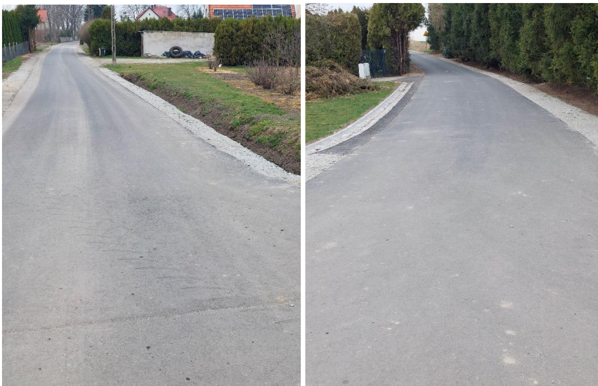
Zdjęcie: Przebudowa drogi dojazdowej do gruntów rolnych w Piotrowicach
