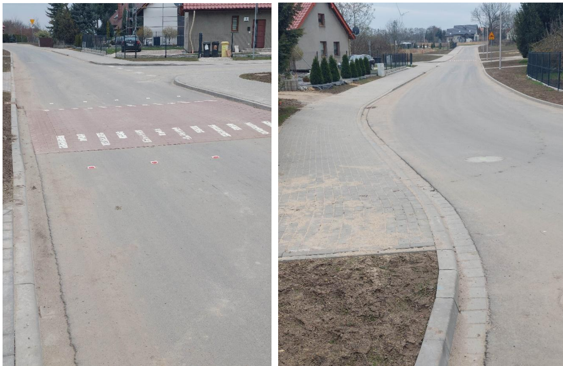
Zdjęcie: Przebudowa drogi ul. Akacyjowa w Kostomłotach
