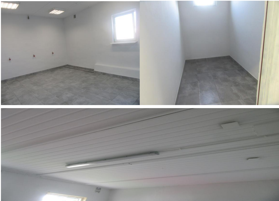
Zdjęcie: Świetlica wiejska w Piotrowicach (pomieszczenia siłowni) - stan po remoncie
