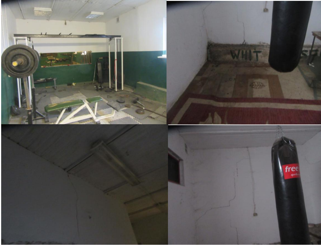
Zdjęcie: Świetlica wiejska w Piotrowicach (pomieszczenia siłowni) - stan przed remontem
