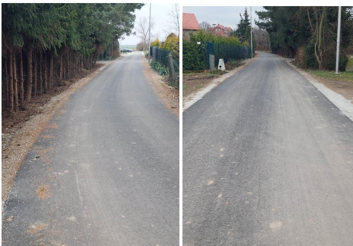
Zdjęcie: Przebudowa drogi gminnej w miejscowości Kostomłoty ul. Świerkowa
