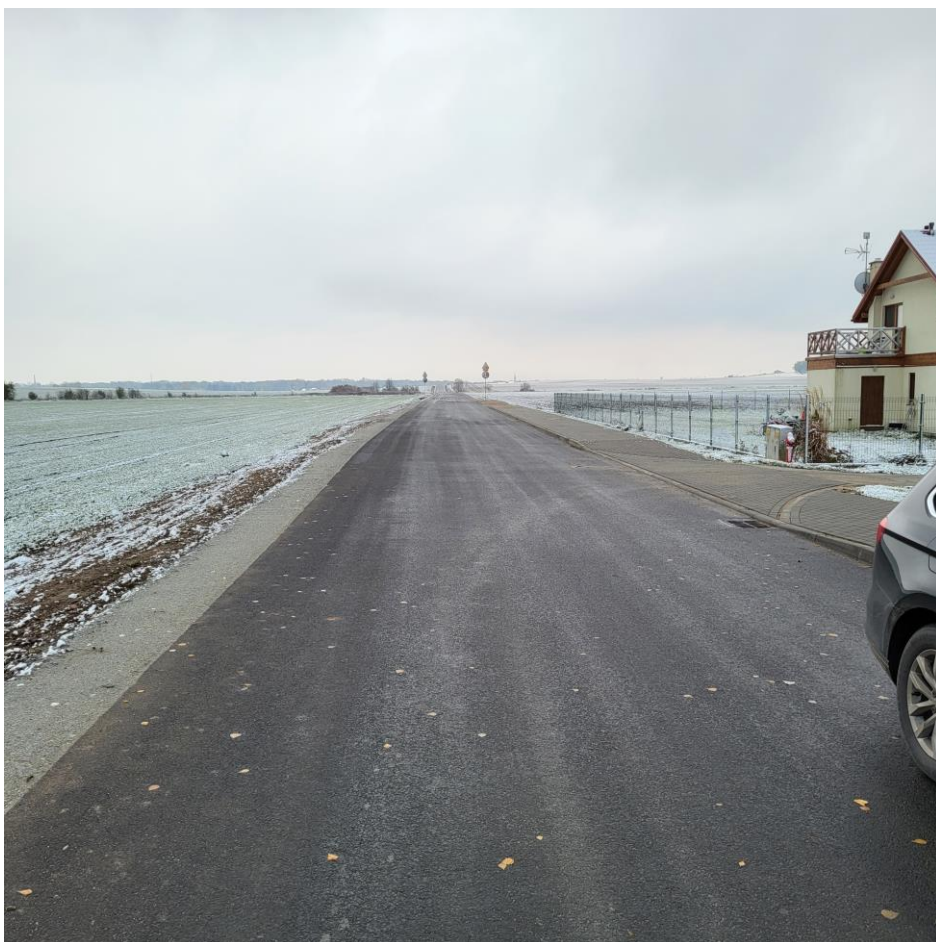
Zdjęcia: budowa drogi gminnej relacji Piotrowice Szymanowice II etap
