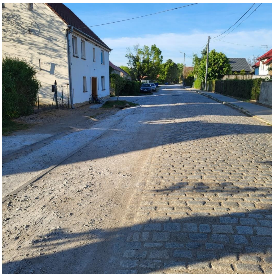
Zdjęcie: przebudowa pobocza Budziszów
