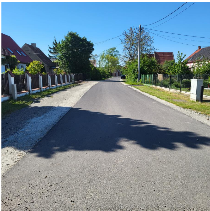
Zdjęcia: Przebudowana droga w miejscowości Wilków Średzki
