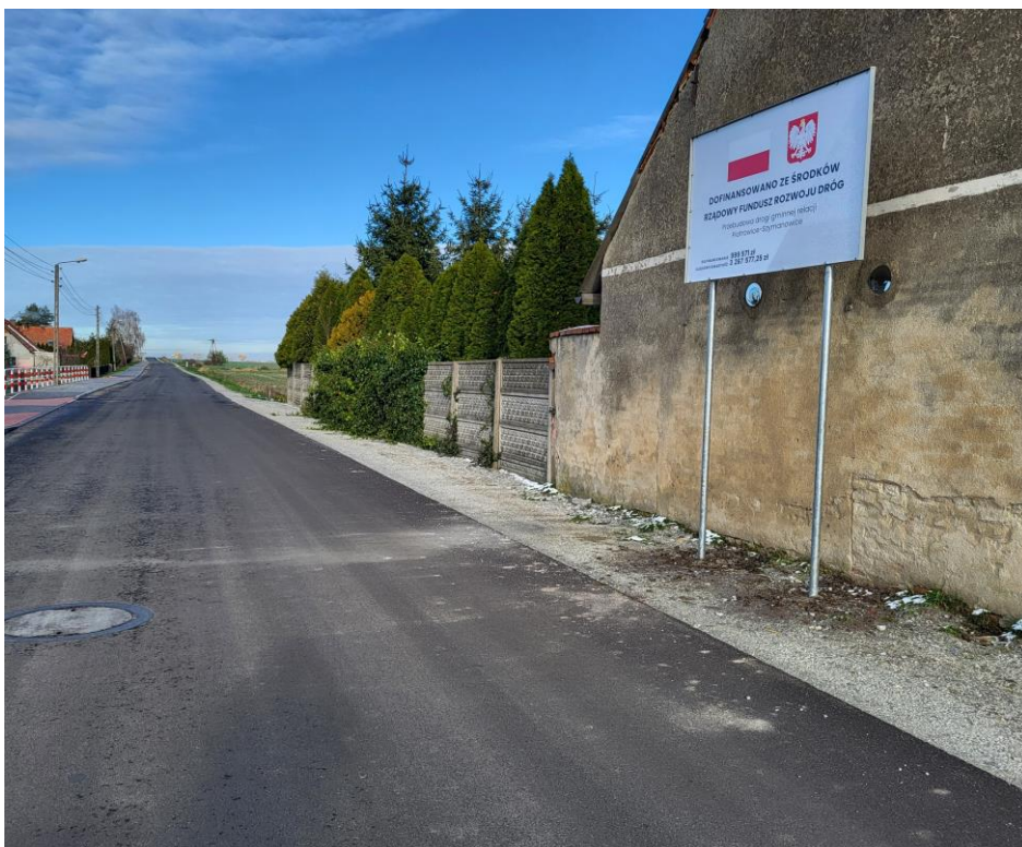
Zdjęcia: budowa drogi gminnej relacji Piotrowice Szymanowice
