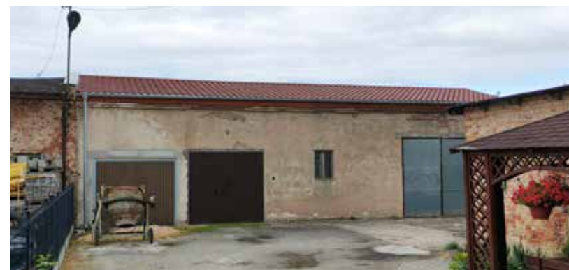
Remont dachu w budynku gospodarczym, ul. Polna 13 w Kostomłotach
