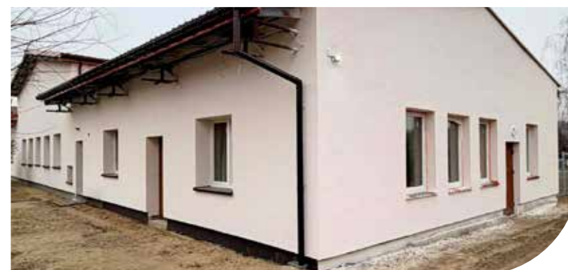
Termomodernizacja świetlicy wiejskiej w miejscowości Godków
