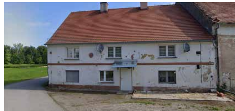
Remont dachu budynku mieszkalnego nr 43 w miejscowości Piersno
