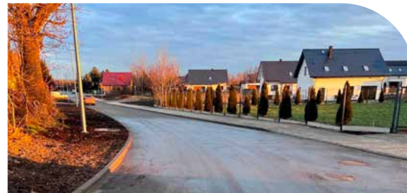
Przebudowa ul. Akacjowej w Kostomłotach
